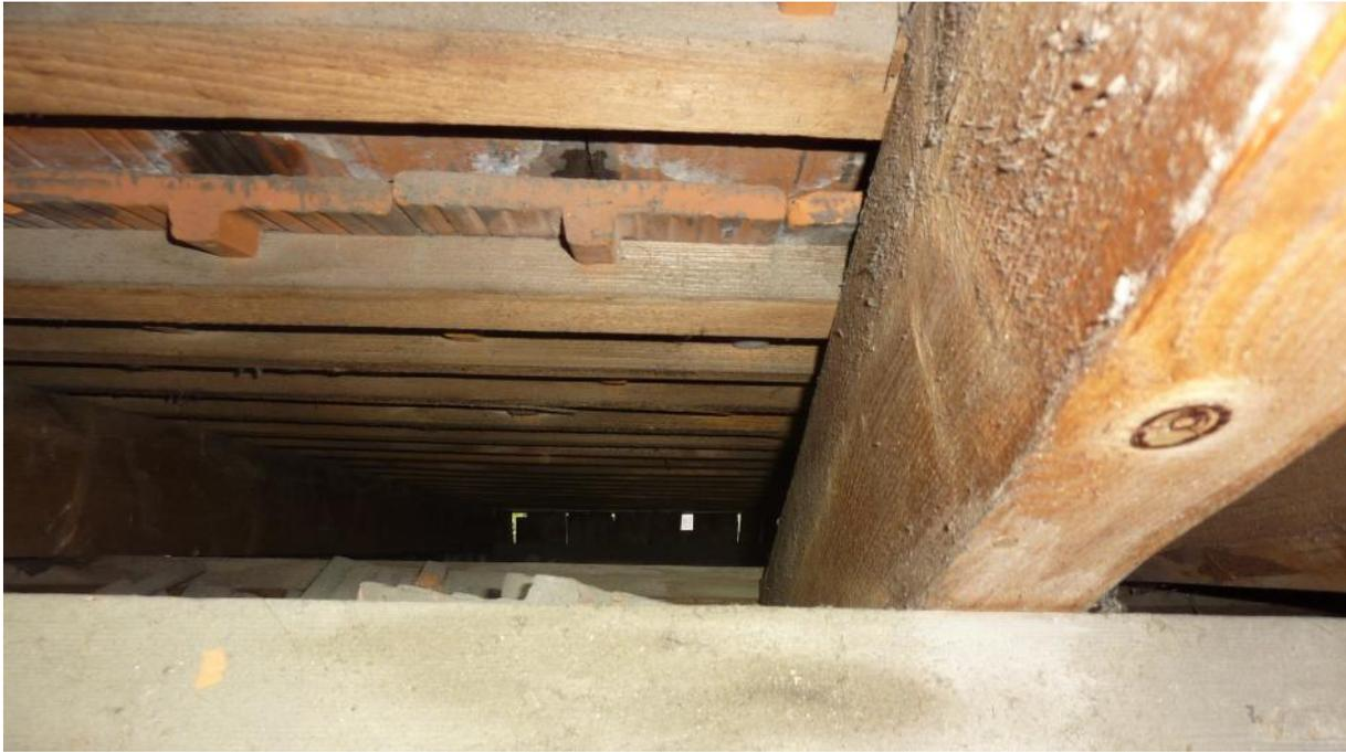
**Abbildung 12: Öffnungen im Traufbereich. Diese finden sich auf beiden Längsseiten des Gebäudes an mehreren Stellen im Traufbereich.**
