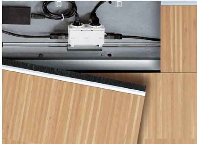
Revisionierbarer integrierter Bodenkanal
