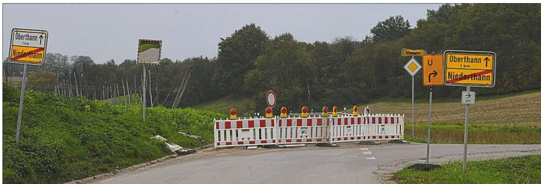
Im gesamten Gemeindegebiet von Schweitenkirchen gibt es zur Zeit Teil- und Vollsperrungen wie hier zwischen Niederthann und Oberthann. Neben der Verlegung von Mittelspannungsleitungen trägt auch die Verlegung von Glasfaserleitungen hierzu bei. Fotos: Schmid
