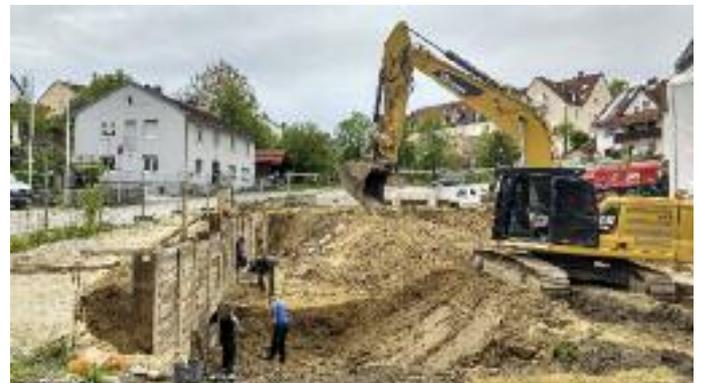
Nur kurz nach diesem offiziellen Festakt, rückte bereits das erste beeindruckende Baugerät an, welches, wie von Statiker Nikolaus Reisner beschrieben, zur Festigung des Untergrundes dient. Eine Pfahlgründung ist nötig, da der Boden sandig-lehmig und nicht tragfähig ist. Massive Eisenträger wurden in der Tiefe versenkt.
